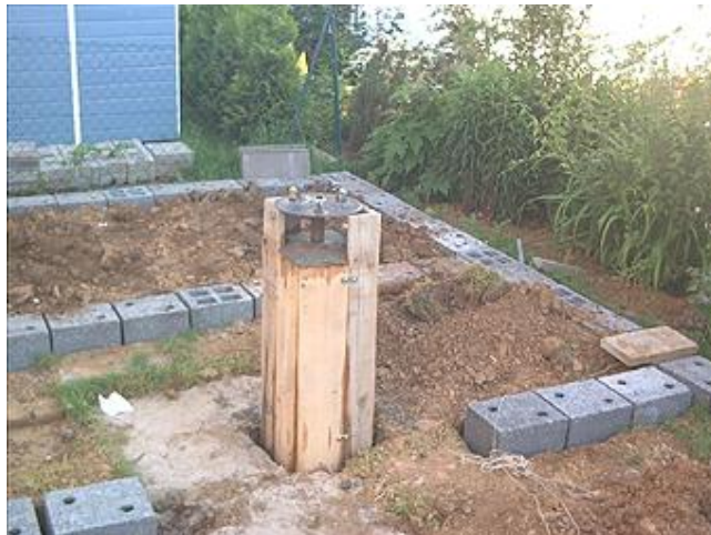
Verschalung und fertiges Ausgießen der Fernrohrsäule mit Grundplatte
