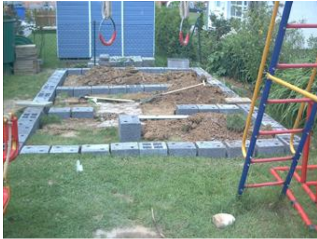
Betonsteinfundament für Seitenwände
