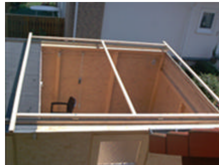
Dachgerüst auf den Laufschielen
